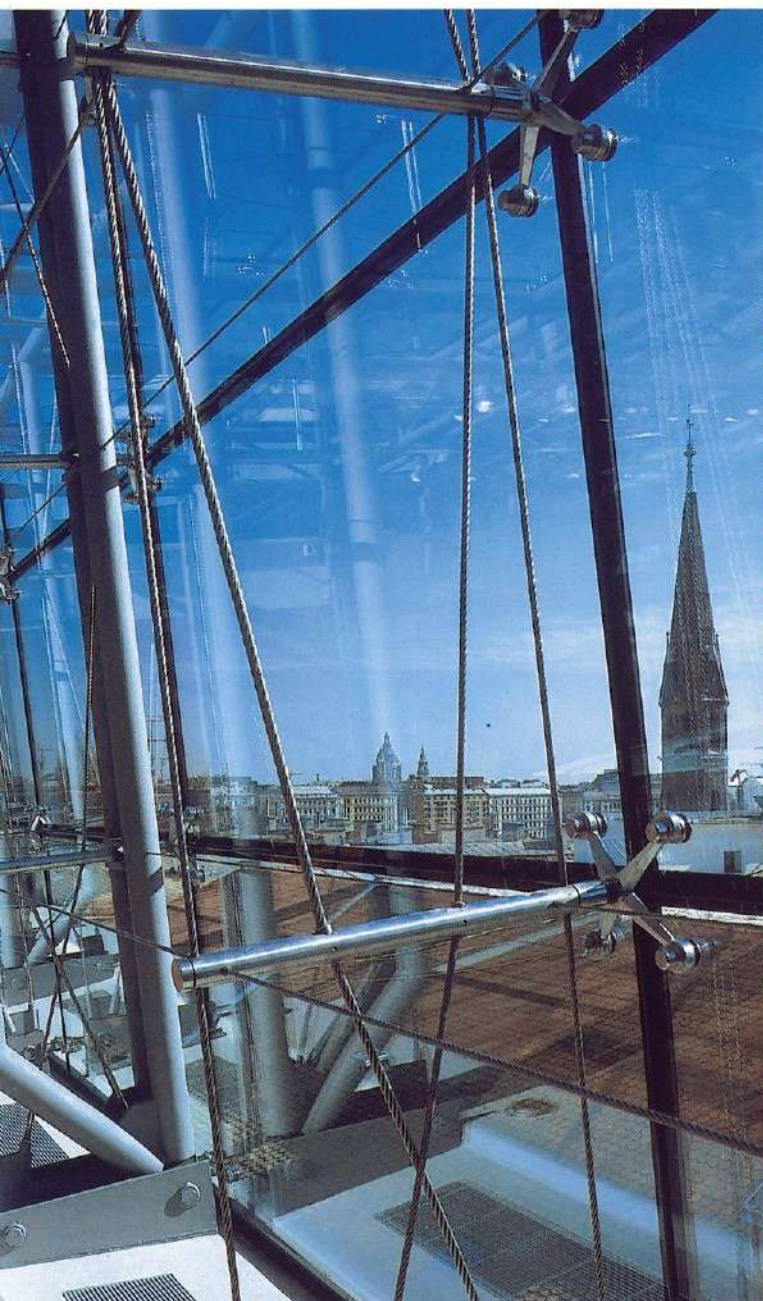
A teliüveg doboz tere és a pontmegfogású üvegfal részletei a város tornyaival The glass box and the details of the point-fastened glass wall, with the towers of the city
